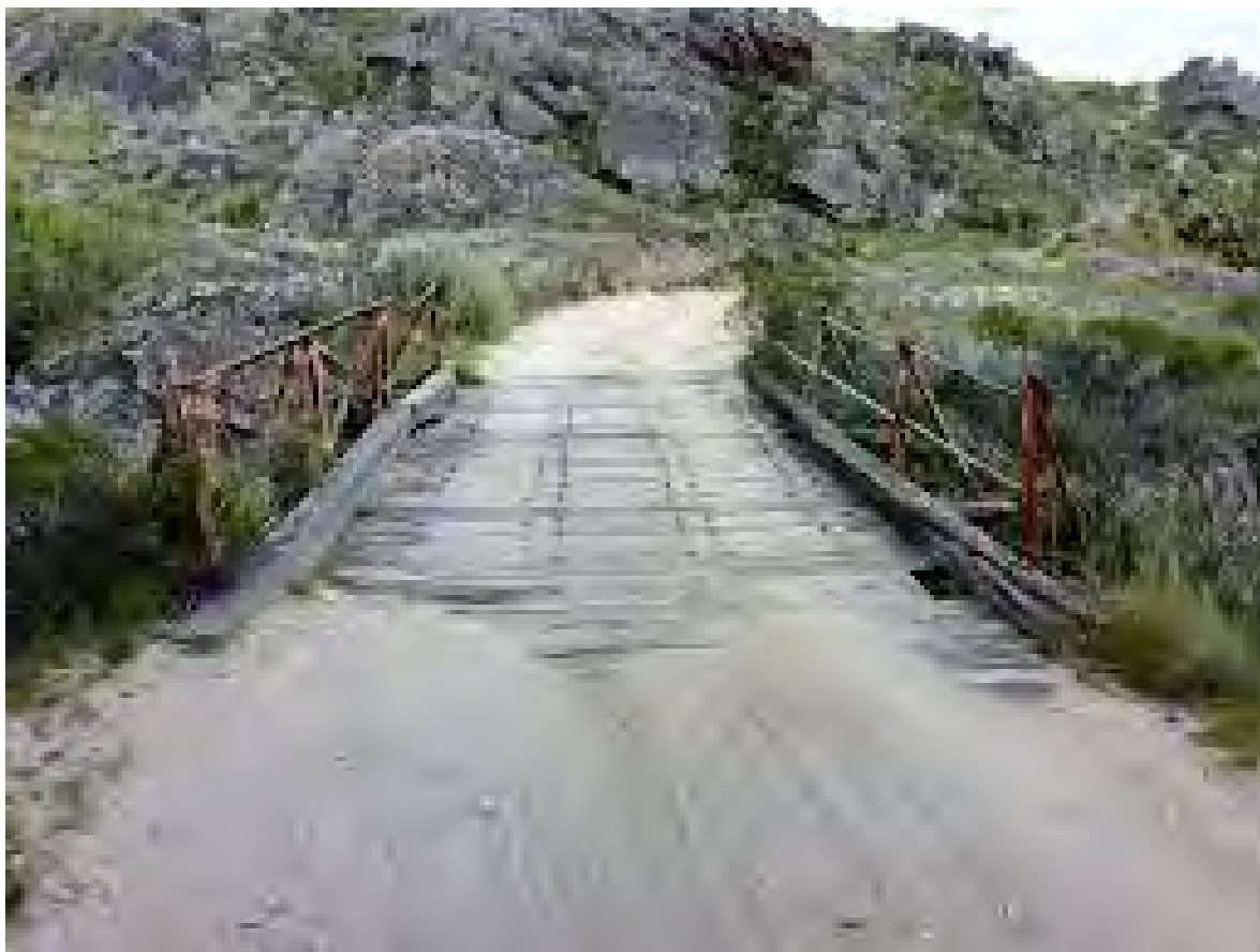
(Vista del puente sobre la quebrada del río Tania)
